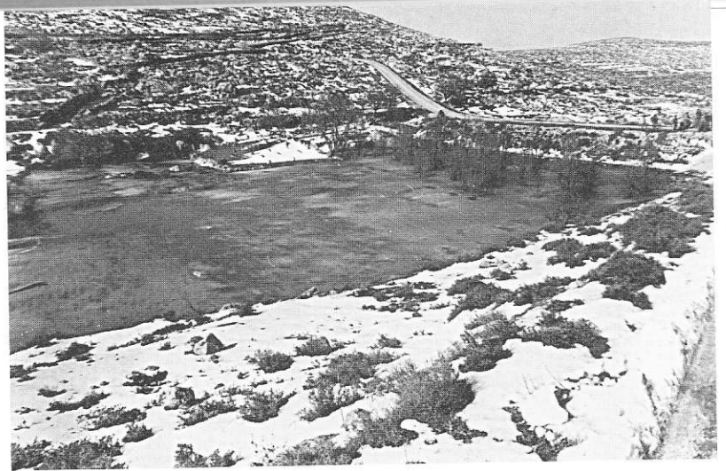
איור 10: הסכר בוואדי ביאר, מבט לצפון-מערב
